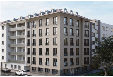
Mehrfamilienhaus Olgastraße in Stuttgart, 14 Einheiten
